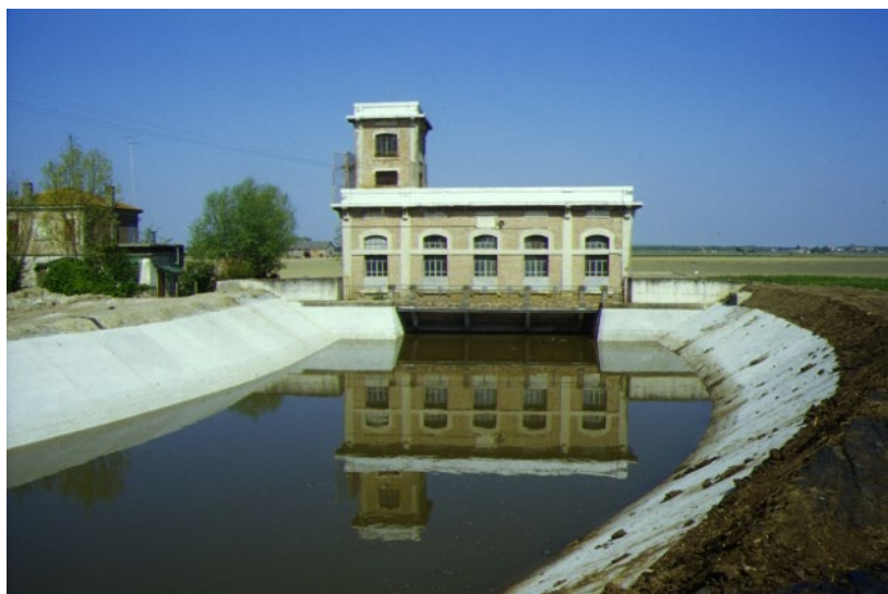
Figura a sinistra: Impianto Idrovaro Salghèa.
