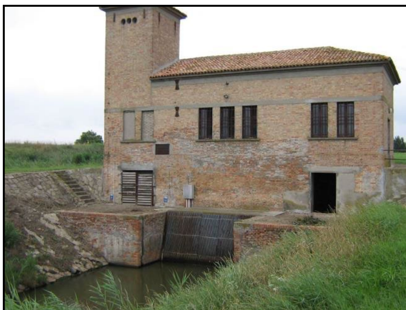
Veduta da monte dell'Impianto Idrovaro Staffano (priv.).
