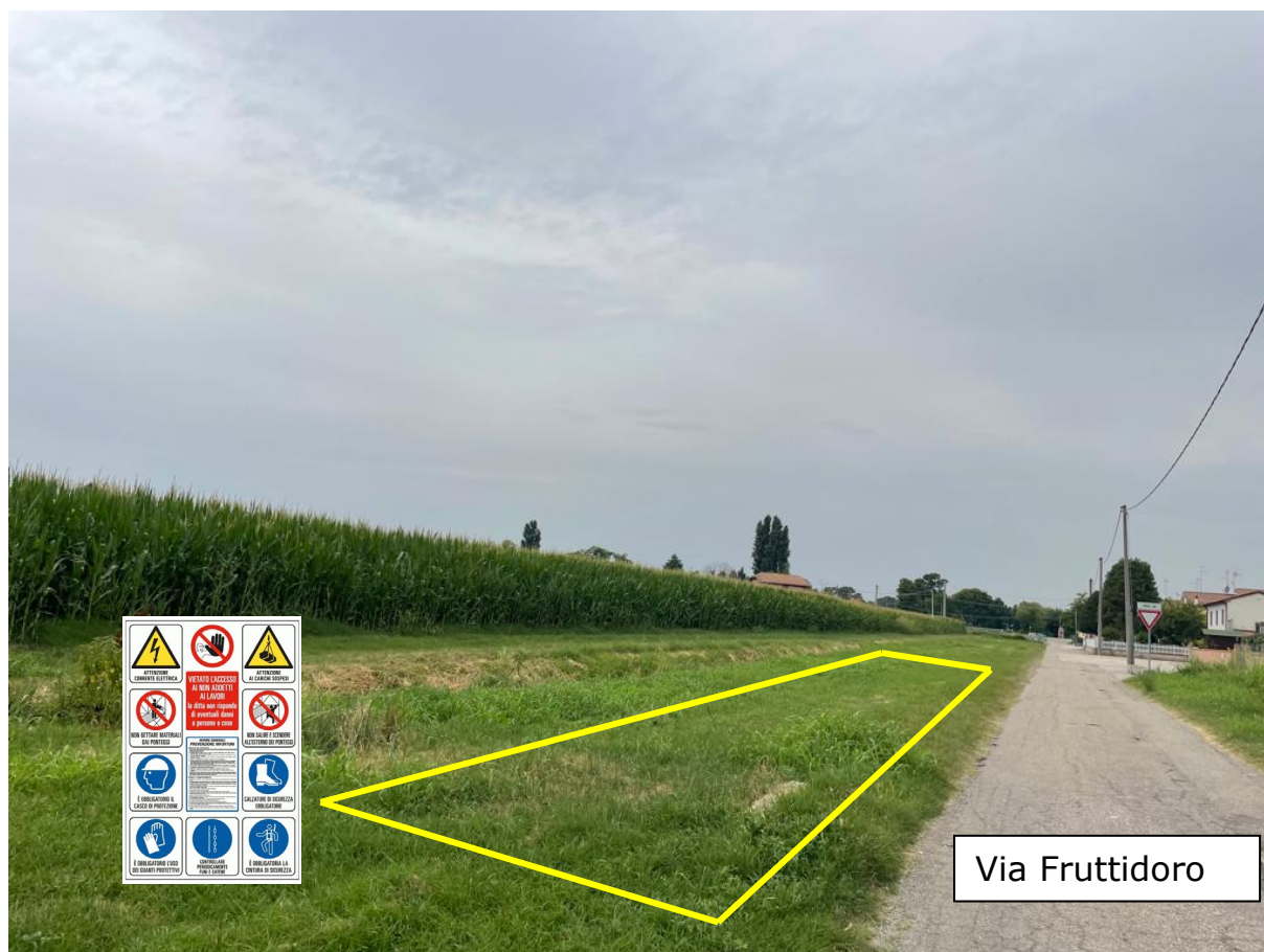
Figura 3. 1° Campo Base – Baracca di cantiere, deposito mezzi e materiale, WC Occupazione area 50m x 7m - Località Montalbano.
