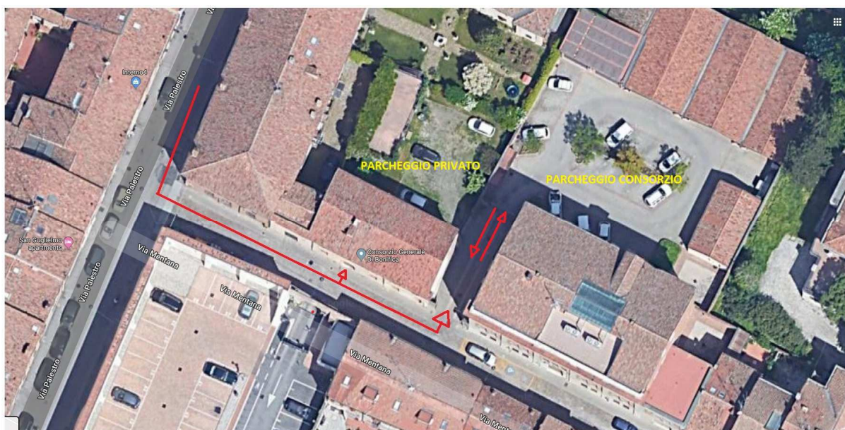
Figura 4. Inquadramento accesso da via Mentana, area parcheggi interni.
