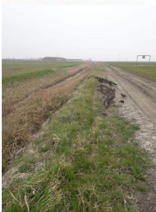
FIGURA - 3 – PARTICOLARI DEL CEDIMENTO SPONDALE
