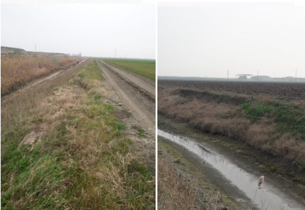
FIGURA - 2 – PARTICOLARI DEL CEDIMENTO SPONDALE
