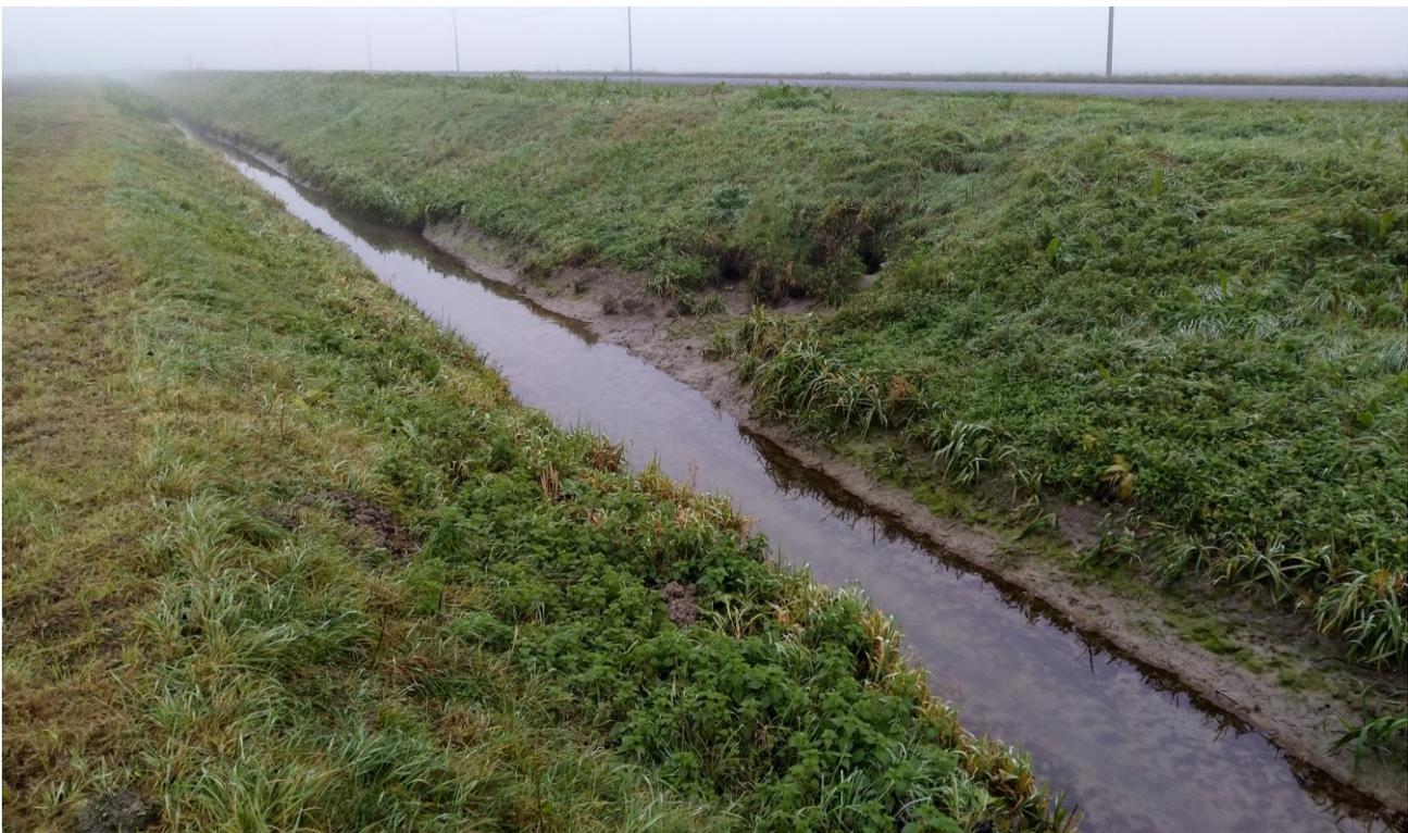
FIGURA - 3 – PARTICOLARE DEL CEDIMENTO SPONDALE
