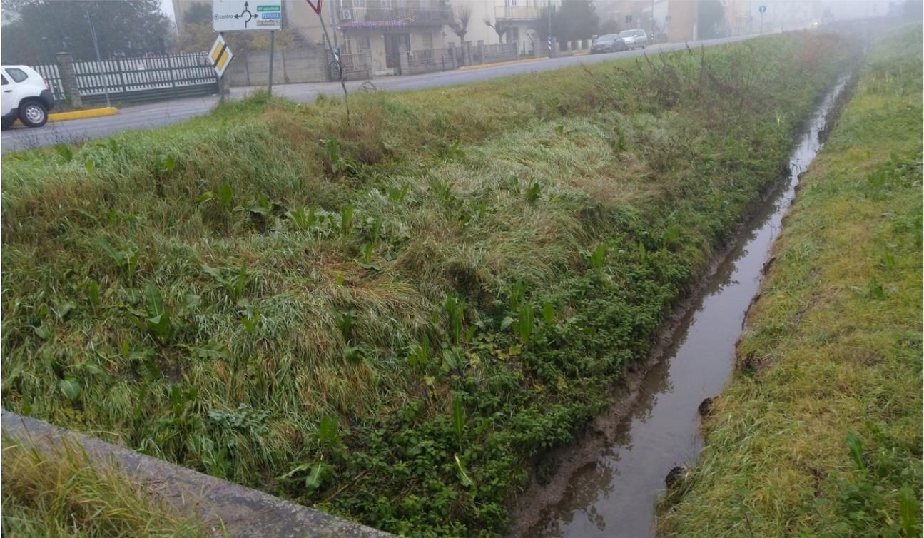
FIGURA - 2 – PARTICOLARE DEL CEDIMENTO SPONDALE
