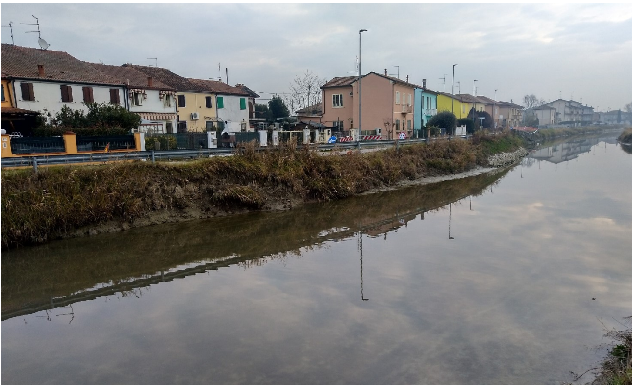
FIGURA - 3 – PARTICOLARE DEL CEDIMENTO SPONDALE
