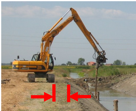
MANTENERE UNA DISTANZA MINIMA DI 1m DA CIGLIO SCAVI
