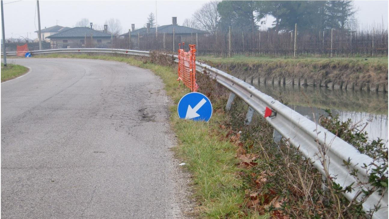
FIGURA - 2 – PARTICOLARE DEL CEDIMENTO SPONDALE
