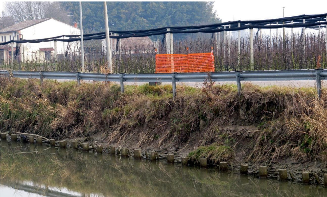
FIGURA - 3 – PARTICOLARE DEL CEDIMENTO SPONDALE
