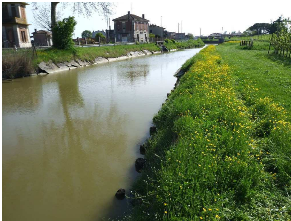
Figura 5: vista del tratto interessato da valle verso monte.
