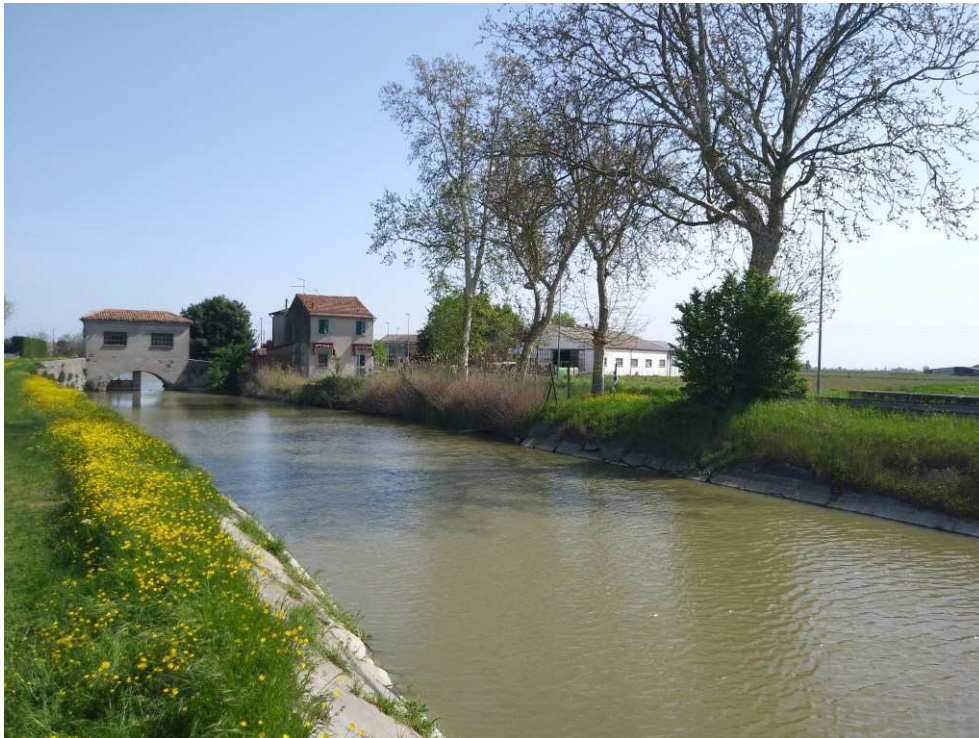
Figura 4: vista del tratto interessato da monte verso valle.
