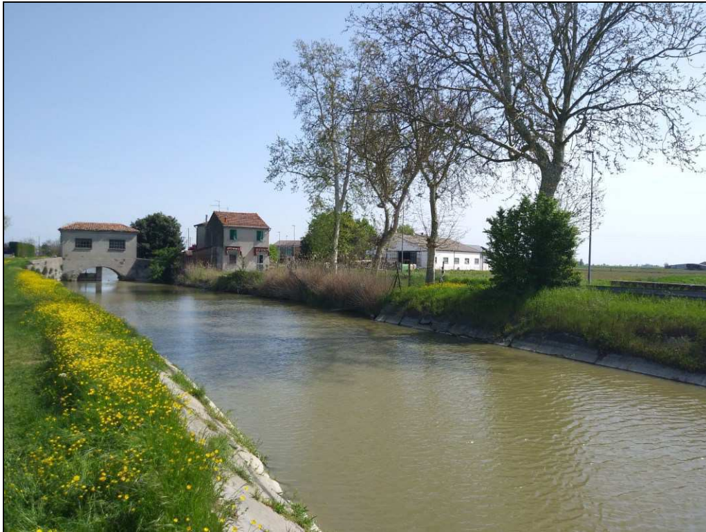
Figura 3. Vista del sito dalla sinistra idraulica del Canale Naviglio. In fondo è visibile il manufatto esistente.
