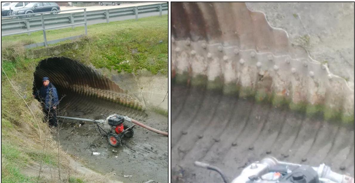
*Figura 4: Foto dello stato di fatto del tubo da sostituire*
