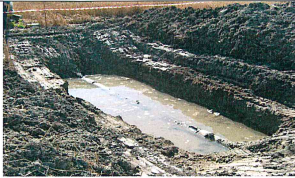
Particolare scavo - Tubo immerso in acqua
