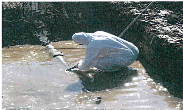
Particolare rottura - Tubo segato a mano
