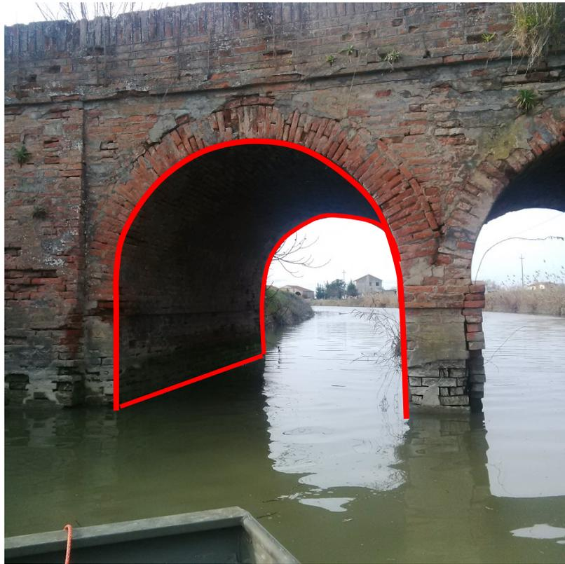
Ristilatura dei giunti di malta delle volte, delle pile, delle spalle e dei timpani per garantire il ripristino della parte corticale
