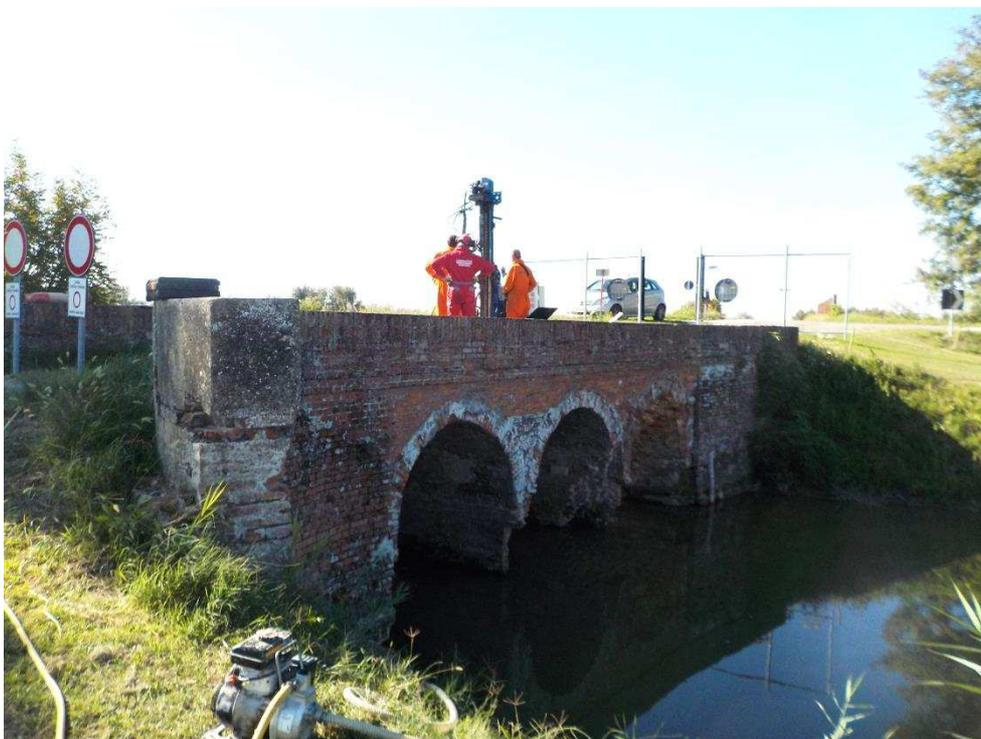
Figura 23: esecuzione del sondaggio S1
