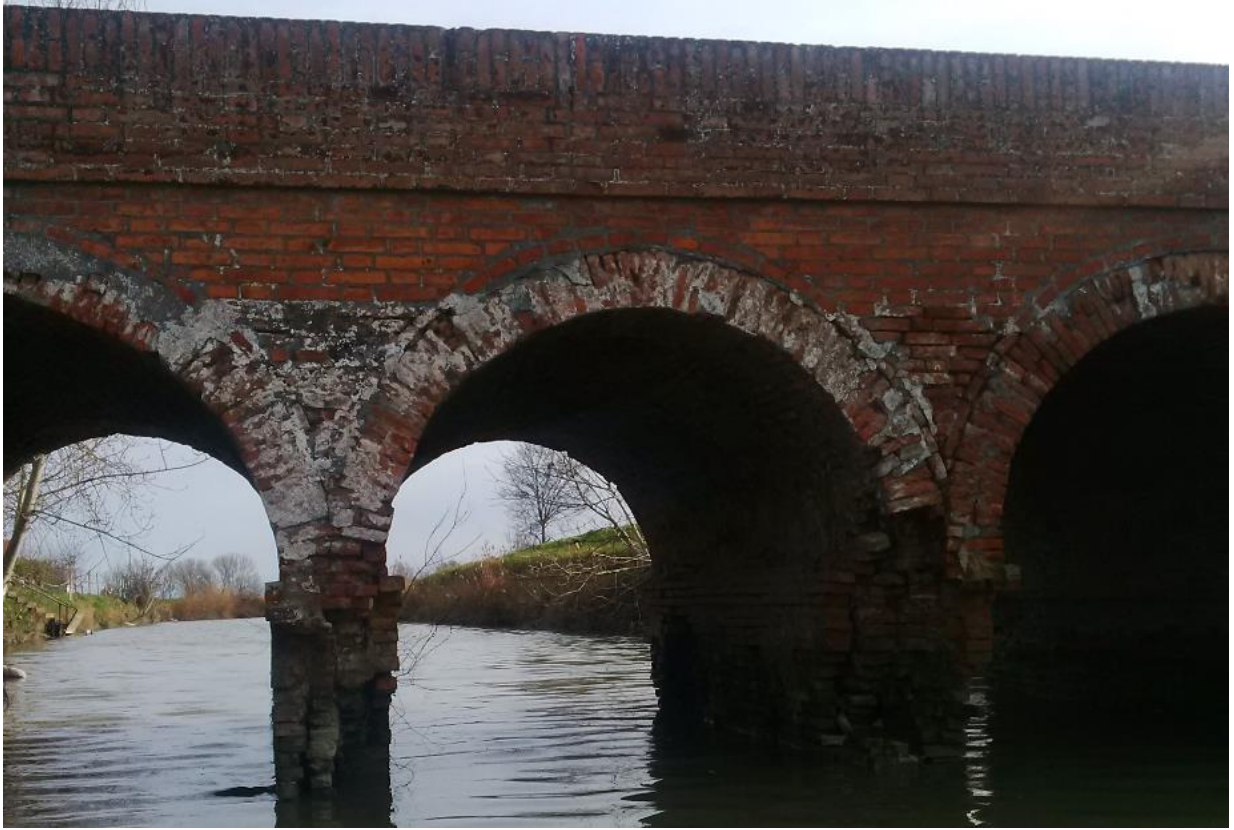
Figura 7: Dettaglio seconda arcata vista da monte
