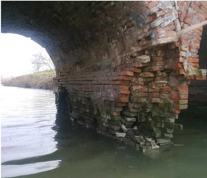
Figura 11: Dettaglio Pila 2 vista da monte
