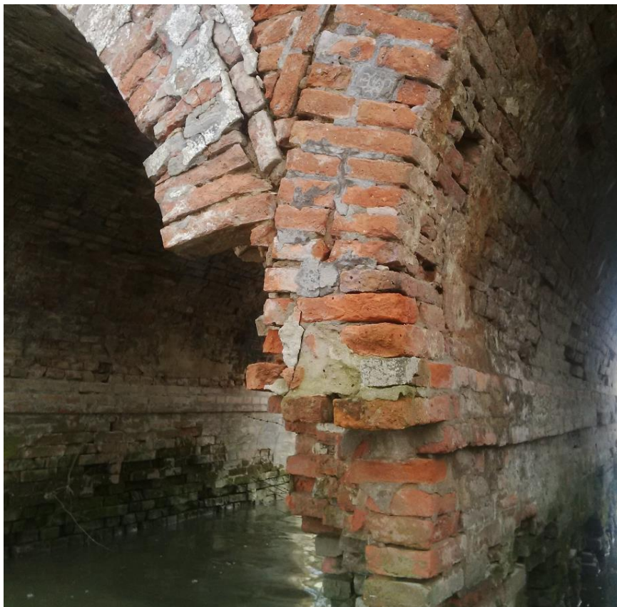
Figura 12: Dettaglio scarico archi su Pila 2
