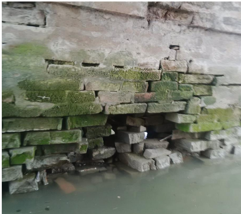
Figura 14: Dettaglio Pila 2 zona bagnasciuga
