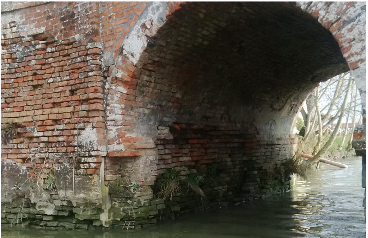
Figura 8: Dettaglio paramento spalla SX vista da monte
