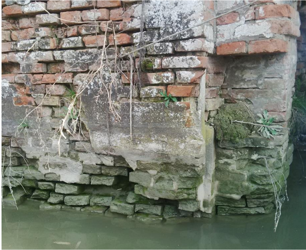
Figura 9: Dettaglio spalla SX vista da monte
