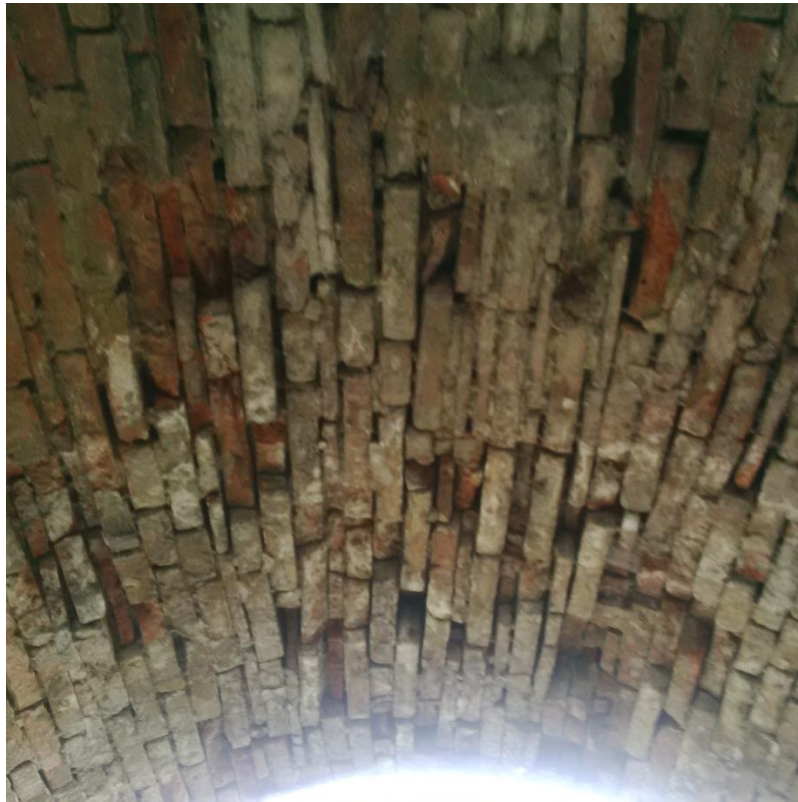
Figura 13: volta a botte prima arcata
