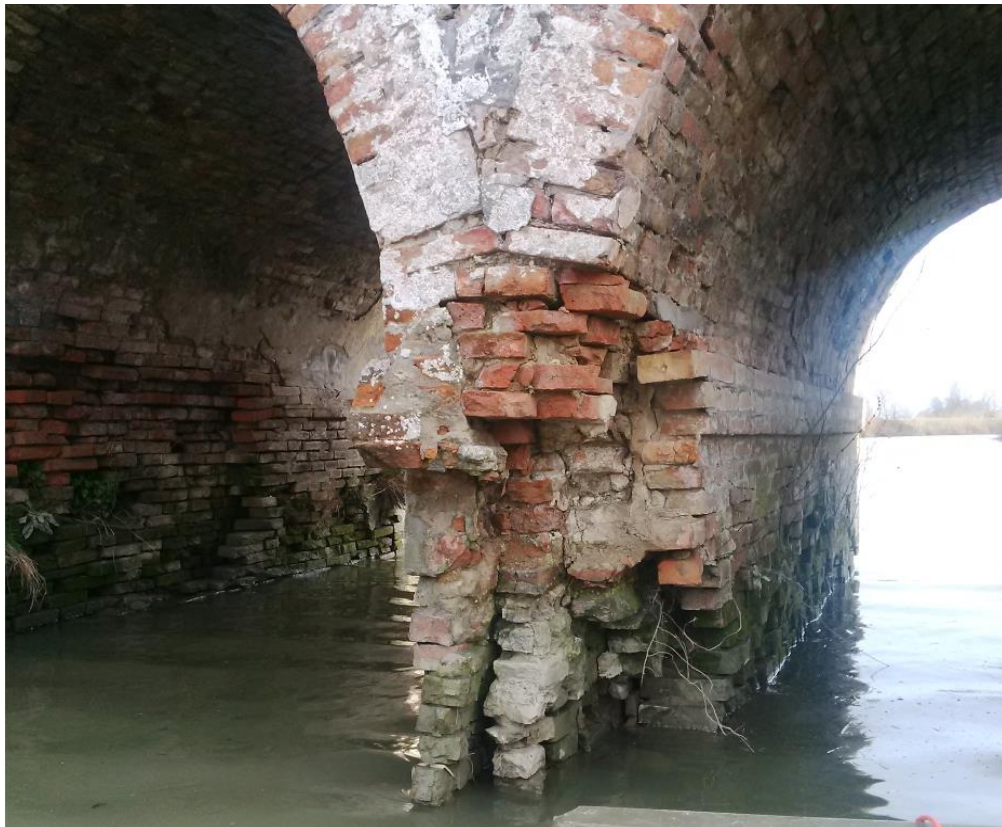
Figura 10: Dettaglio Pila 1 vista da monte
