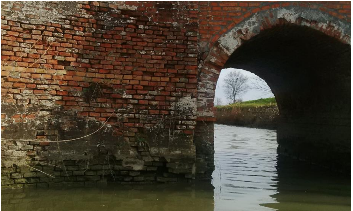
Figura 5: Dettaglio Spalla SX vista da monte
