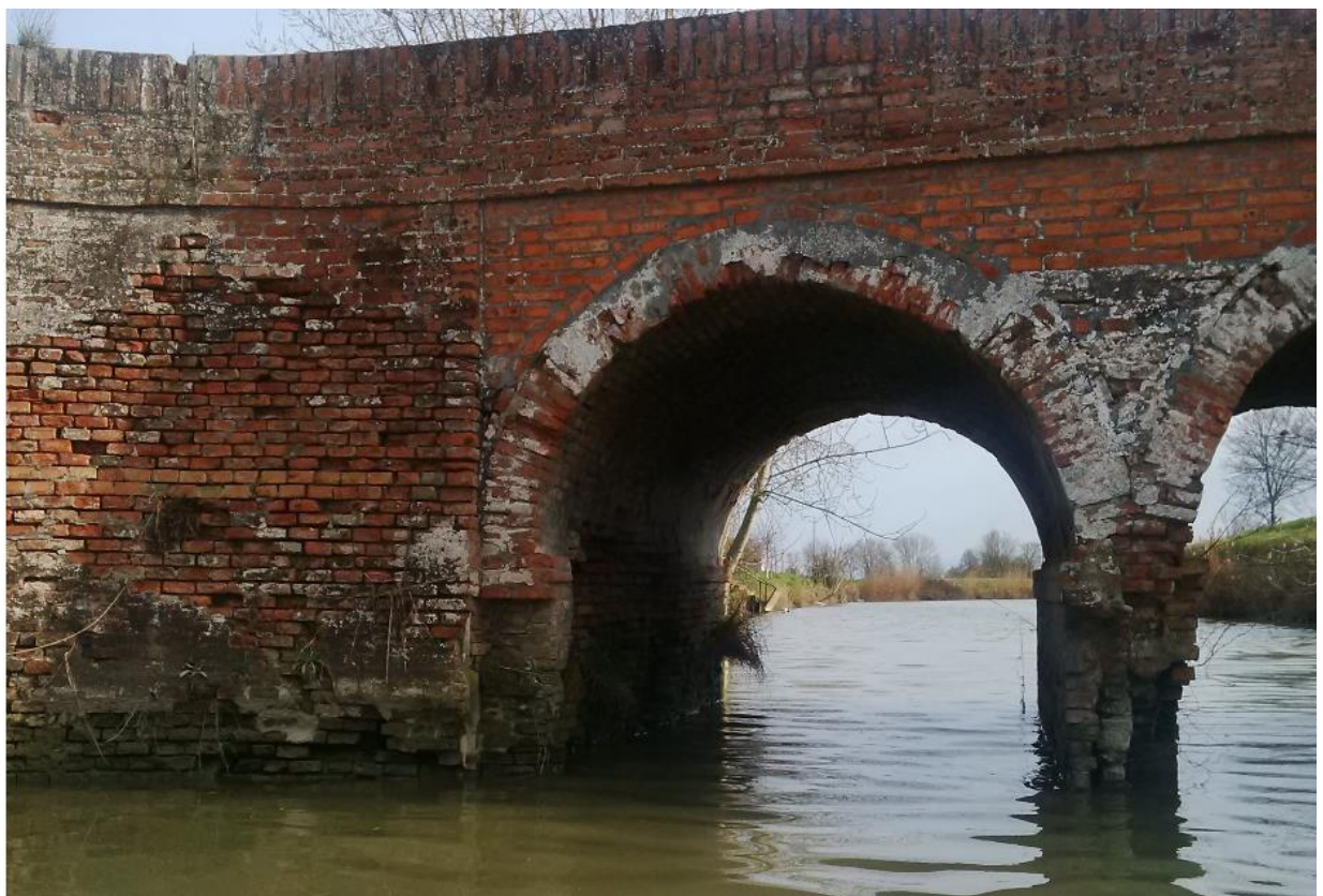
Figura 6: Dettaglio Spalla SX e prima arcata vista da monte
