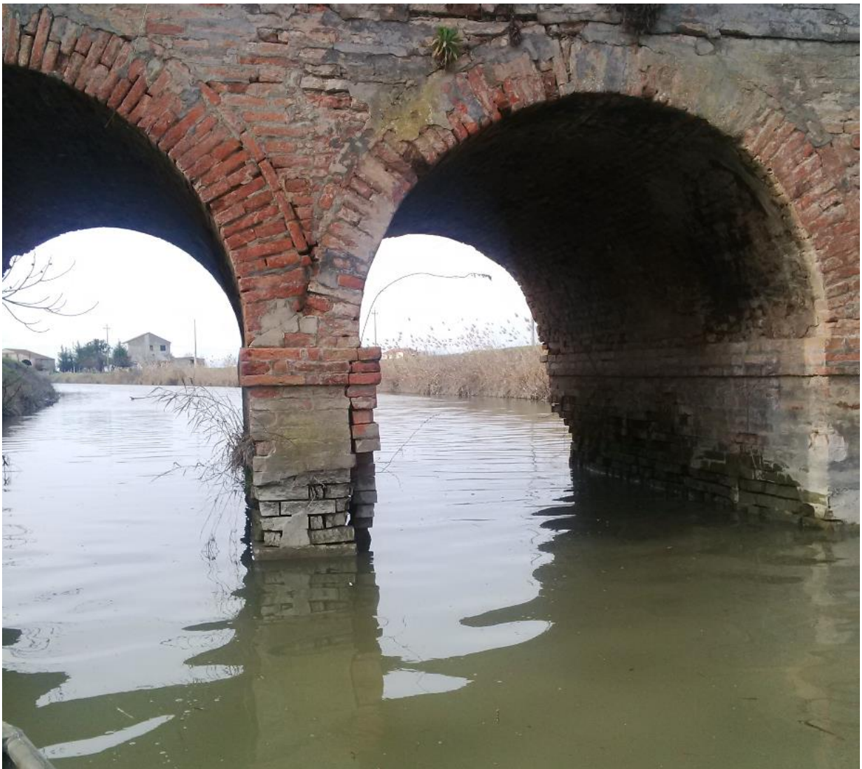
Figura 17: Pila 1 vista da valle
