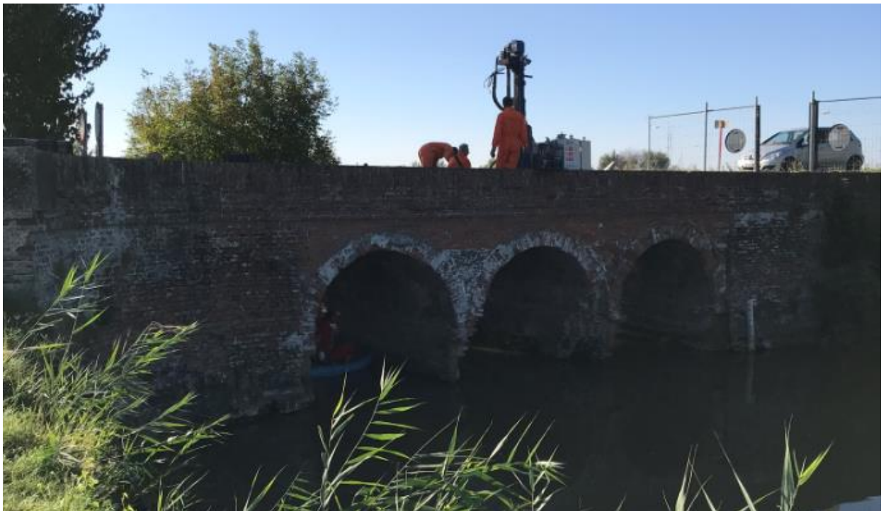
Figura 2: Ponte Prafitta – Prospetto di monte
