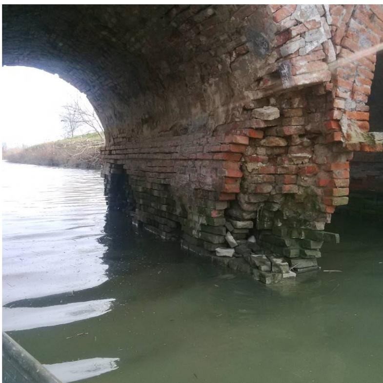
Figura 4. Ponte Prafitta Bertolina - Muratura in avanzato stato di degrado
