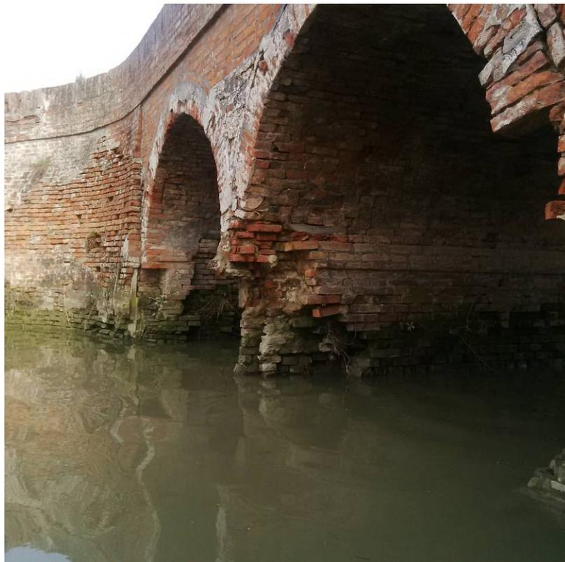
Figura 7. Ponte Prafitta Bertolina - Muratura in avanzato stato di degrado
