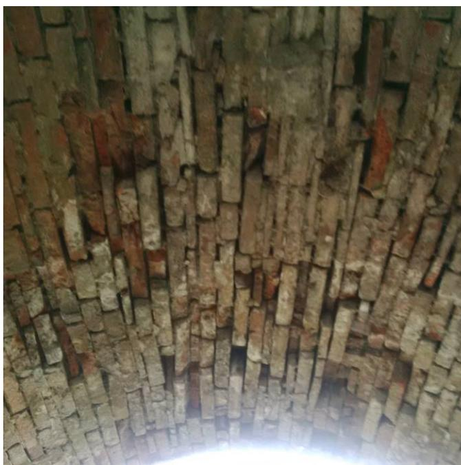
Figura 6. – Distacchi di muratura e mancanza di giunti di malta sulla sommità della volta
