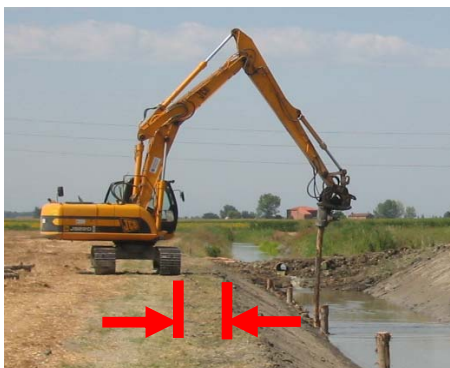
MANTENERA UNA DISTANZA MINIMA DI 1m DA CIGLIO SCAVI
