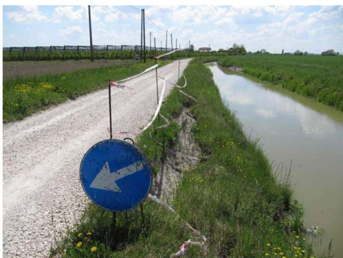
FIGURA - 3 – PARTICOLARE DEL CEDIMENTO SPONDALE
