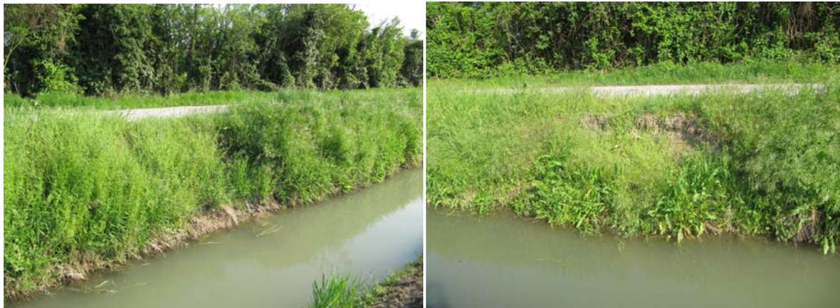
FIGURA - 2 – PARTICOLARI DEL CEDIMENTO SPONDALE
