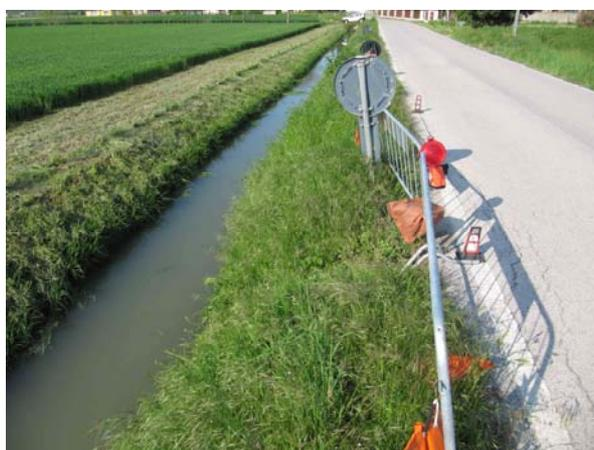
FIGURA - 3 – PARTICOLARI DEL CEDIMENTO SPONDALE
