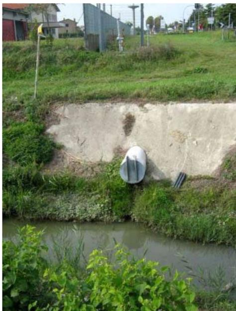
Le immissioni ai punti 1 e 3 nel Canale Galvano, secondo gli studi effettuati dal C.A.D.F., possono superare complessivamente la portata di 6 mc/s e sono ubicate a valle dell'Impianto Idrovero di presollavamento Bosca, arrivando a provocare vistosi innalzamenti del livello del canale, fino a sommergere lo stesso tubo di scarico fognario al punto n.1 in
