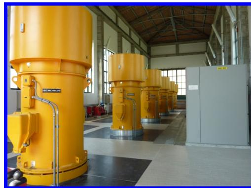
**Impianto Intermedio 1**, realizzato nel secondo dopoguerra per trasferire una portata massima di  $12 \text{ m}^3/\text{sec}$  dal collettore di Acque Basse al collettore, e relativo impianto idrovoro, di Acque Alte
