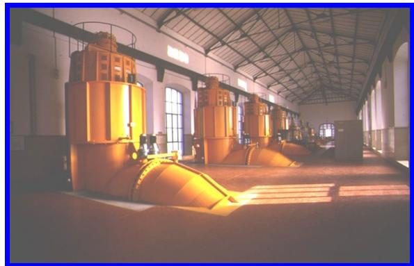
**Nuovo Impianto di Acque Alte**, terminato nel 1995 e dotato di sei elettropompe per una portata complessiva di circa  $50 \text{ m}^3/\text{sec}$ :
