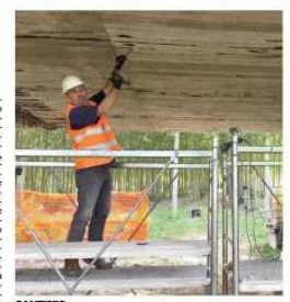
CANTIERE Un'opera al lavoro al Ponte Nuovo che attraversa il Reno
