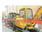
Lavori alla sponda del canale di via Muratori a Comacchio
