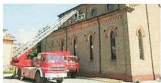
L'inaugurazione dei lavori della chiesa gavello dopo il terremoto del 2012
