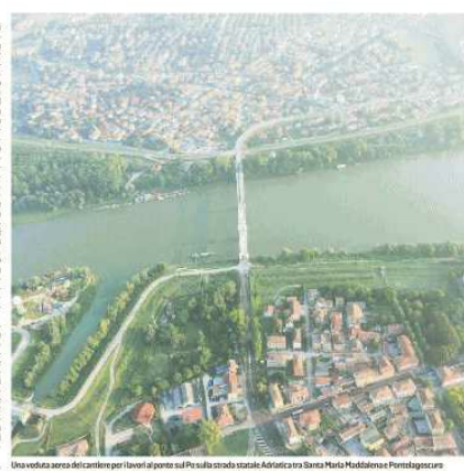
Una veduta aerea del cantiere per i lavori al ponte sul Po sulla strada statale Adriatica tra Santa Maria Maddalena e Pontelagoscuro
