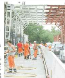
Lavori in corso sul ponte tra Gallo e Malalbergo
