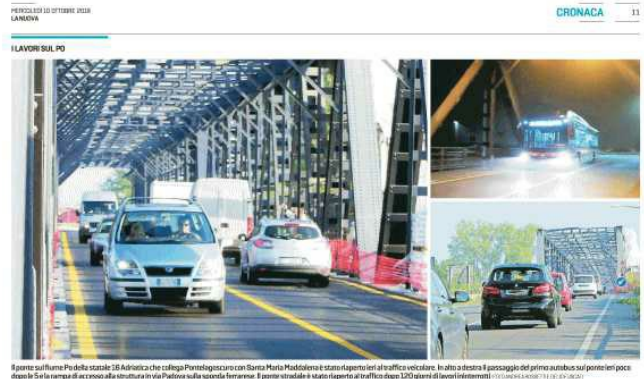
Il nuovo sull'area Padovana-Profilo della struttura in via Padova sulla sponda ferrarese. Il ponte stradale è stato aperto al traffico dopo 120 giorni di lavori ininterrotti. In alto a destra il passaggio del primo autobus sul ponte ieri poco dopo le 5. La rampa di accesso alla struttura in via Padova sulla sponda ferrarese. Il ponte stradale è stato aperto al traffico dopo 120 giorni di lavori ininterrotti
