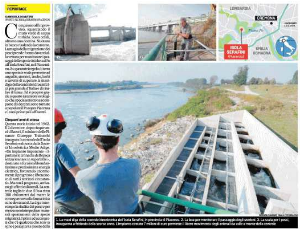
1. La maxi diga della centrale idroelettrica dell' isola Serafini, in provincia di Piacenza. 2. La linea per permettere il passaggio degli storioni. 3. La scala per i pesci, fotografata a febbraio dello scorso anno. L' impianto costerà 7 milioni di euro per metà a fondi europei
