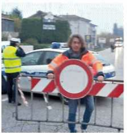
Via in transito, dopo quasi due mesi di lavoro il riprende regolarmente la circolazione tra Cento e Pieve
