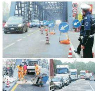
Lavori al ponte: un cantiere sul ponte del Po, le code chilometriche in via Padova e il traffico a senso unico
