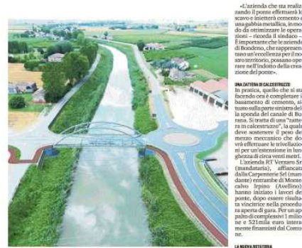
Il cantiere che mostra come sarà il nuovo ponte di Borgo Scala a Bondeno
