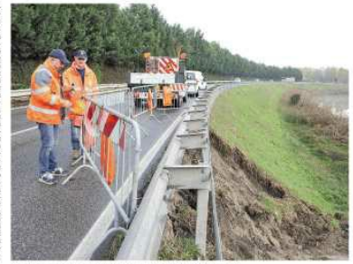
Tecnici e volontari sono al lavoro per garantire la sicurezza delle strade
