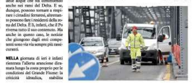
Il cantiere in corso di lavori sul ponte sul Po.
