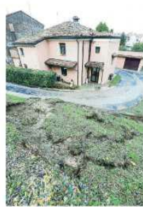
Smottamenti in via Comunale per Stellata a Bondeno
