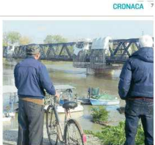
Laporta del Po passa sotto il ponte stradale che da oggi sarà parzialmente con il senso unico alternato
