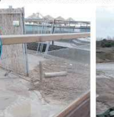
MICCOLI DELLA REGIONE EMILIA-ROMAGNA - per contrastare il rischio di ingressione marina, con il posizionamento di sacchi a protezione dell'erosione, e faremo altrettanto, insieme al Comune, per la zona del Portocanale di Porto Garibaldi, che presenta problematiche di ingressione, sifonamento e la rottura di un muro in zona San Pietro. Con il miglioramento delle condizioni climatiche poi, si potrà inoltre pensare a ulteriori interventi per riportare sabbia sulla costa.
