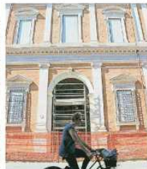
Palazzo Massari. Il restauro della facciata è terminato. A. PUFFETTI
