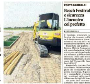
Lavori alla vasca di contenimento del Cadf
