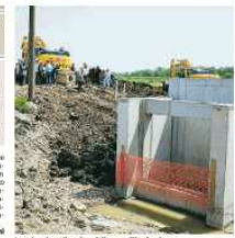
Lavori per la realizzazione della cassa di laminazione
