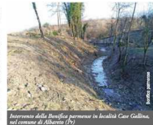
Intervento della Bonifica parmense in località Case Galline, nel comune di Alberto (Pr)
