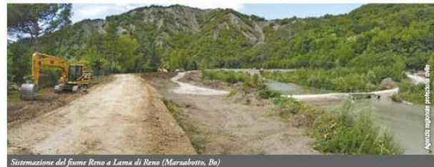
Sistemazione del fiume Reno a Lama di Reno (Marzabotto, Bo)
