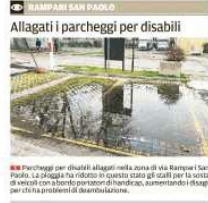
Parcheggi per disabili allagati nella zona di via Rampari San Paolo. La pioggia ha ridotto lo spazio strada gli stalli per la sosta di veicoli con autoveicoli di handicap, aumentando il disagio per chi ha problemi di deambulazione.
