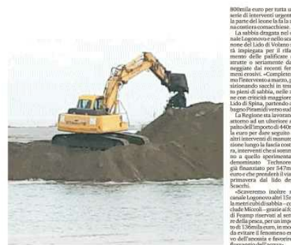
Lavori di scavo del canale Logonovo tra Estense e Spina: la sabbia rafforzerà le barriere di difesa della costa
