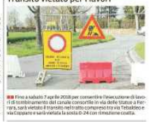
Fino a sabato 7 aprile 2018 per consentire l'installazione di Ferrar... la Provincia interverrà sulla base di fondi ricavati in accordo con la Bonifica.
