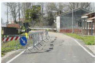
COLLETTORE La sponda del canale a Burana l'8 marzo scorso e ha interessato una sezione di metri della sponda del Collettore: l'intero tratto è transennato
