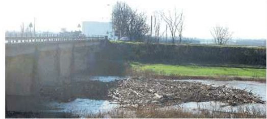
L'erosione del letto del fiume Reno in località Ponte Bastia dove ha formato il cosiddetto effetto lagno
