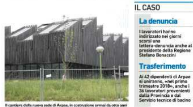
Il cantiere della nuova sede di Arpae, in costruzione ormai da otto anni
