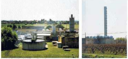
La centrale di Serbelloni per la depurazione dell'acqua di Serbelloni
