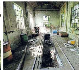
Una zona della stazione officine rimasta scoperta per anni
