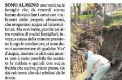
ALLAVORO I tecnici del Cadf impegnati nei lavori di apertura della rete idrica da venerdì scorso
