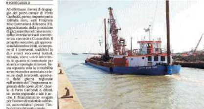
Il nuovo lavoro di dragaggio del porto canale. In alto: Porto Garibaldi e i lidi estivi
