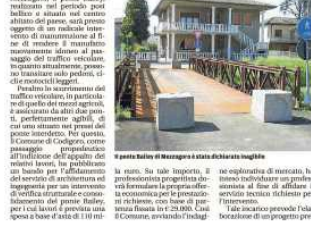
Il ponte Bailey di Mezzogoro è stato dichiarato inagibile.
