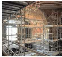
I ponteggi all'interno della chiesa di San Biagio, per l'effettuazione dei lavori di ripristino.
