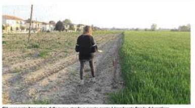
Gli sagomatori il tracciato della nuova strada: a questo punto è imminente l'arrivo del cantiere.
