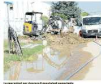
Le operazioni per riparare il guasto nel pomeriggio
