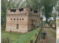
INTERVENTI Il costo complessivo è di 1 milione e 352 mila euro suddiviso in due stralci. Il primo, in corso, è di 722 mila euro. 50 mila euro arrivano dalle donazioni degli sms solidali del sisma 2012, i restanti dalla Regione.
