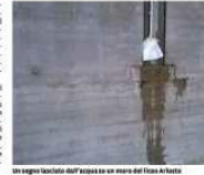
Un lavoro tecnico dell'acqua su un muro del Liceo Ariosto
