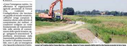
Lavori all'argine della Fossa Marone, a Biondo, dopo le frane causate dalle nebbie che hanno scosso la zona
