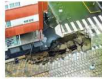
MILANO, 10 LUGLIO 2014. Una voragine di 12 metri di profondità è all' estremità di 5 metri per 3 in una casa della abbandonata piazza a Milano, all' angolo di corso di Porta Romana e via Varesa.
