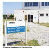
Il ristrutturato palasport di Portomaggiore
