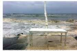
L'erosione del mare è arrivata fino al portico del Privaggio a Lido della Nazione
