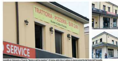
Incendio al ristorante e Pizzeria "Bona e cattiva manna" di Cento: nella foto si vedono le stanze annerite dal fumo dell'edificio
