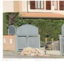
Immediato intervento dei tecnici che hanno provveduto a sigillare la tubatura
