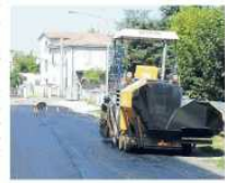
Lavori di asfaltatura in una strada di Poggio Renatico
