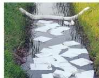
I rifiuti che sono stati rimossi e i lavori di bonifica in corso nel canale inquinato.
