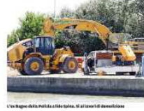
Un bagno della Polizia a Lido di Spina. In alto i lavori di bonifica
