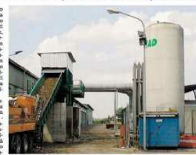
MONANTOLA La ditta Sara sta già da tempo smaltendo per le attività di ampliamento di un impianto
