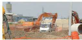
CANTIERI Nella foto (archivio) i lavori per l'installazione della trivella per la ricerca di idrocarburi a Gradizza e stata richiesta l'autorizzazione per un secondo impianto
