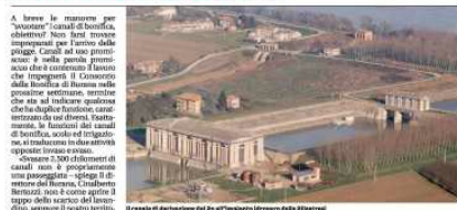
Il canale di Burana dal Po all'Impero Veneto della Pianura
