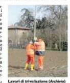
Lavori di trivellazione (Archivio)
