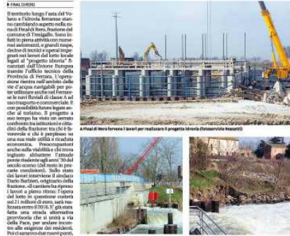
A Final di Rero si lavora per realizzare il progetto Idrovia (Foto: Roberto Bazzani)
