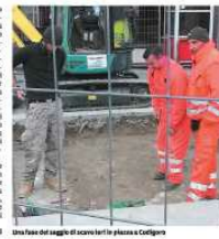
Una foto dei lavori di scavo in piazza a Codigoro
