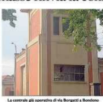
La centrale già operativa di via Borgatti a Bondeno
