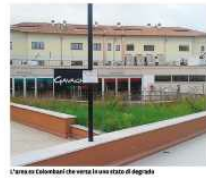
L'area Ex Colombani che versa in un stato di degrado
