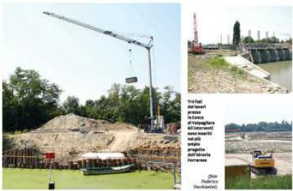
Tralci del nuovo corso dell'Idrovia Ferrarese
